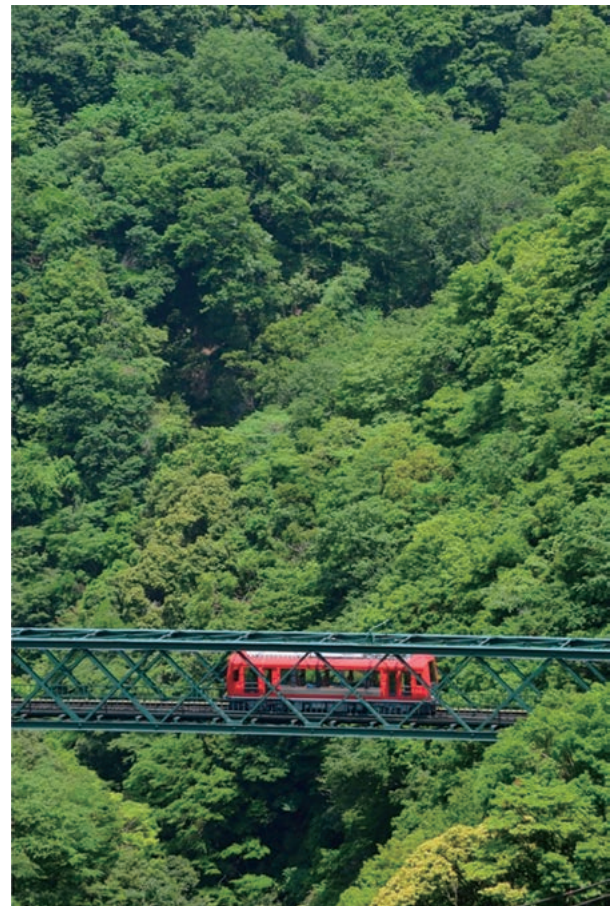
■ 試運転中の3000形電車(早川橋梁) Series 3000 train test run (Hayakawa bridge)
