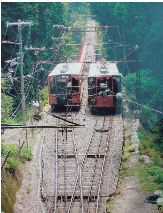
■ 図1 架線があったところのケーブルカー Fig.1 The cable car before removed the line
