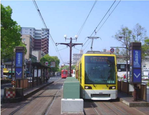
図6 架線電圧補償システム（桜島棧橋通電停） Fig.6 The trolley voltage compensation (Sakurajimasanbashidori)
