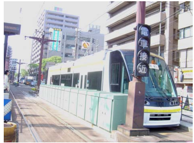
図7 架線電圧補償システム（中洲通電停） Fig.7 The trolley voltage compensation (Nakasudori)
