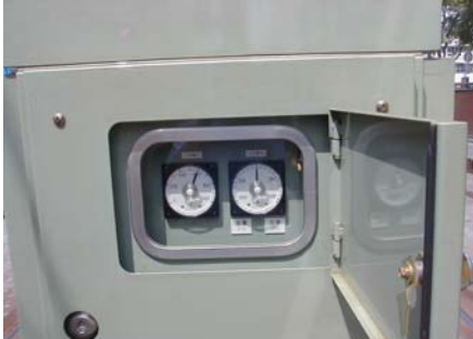
図3 架線電圧補償システム側面カバー部 Fig.3 Side cover of the trolley voltage compensation system
