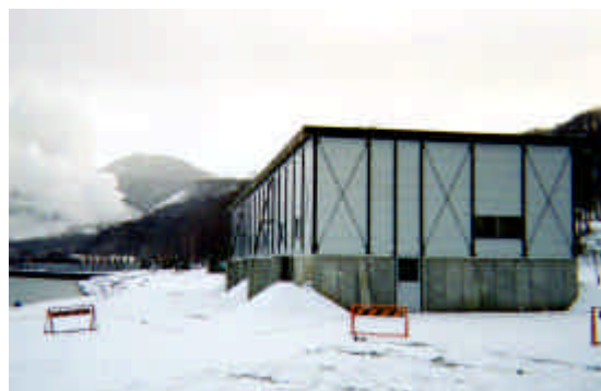
洞爺湖畔仮設浄水場
