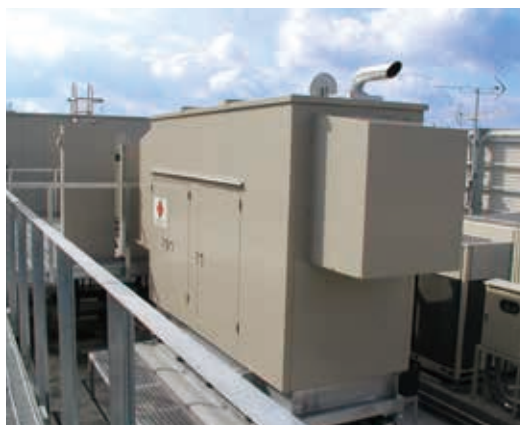
タンデム発電装置収納施設
