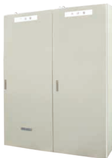
高速電源切替装置収納制御盤
