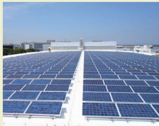
横浜製作所工場棟の屋上に設置中の太陽光パネル
