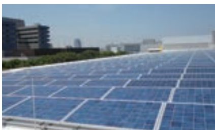
横浜製作所の太陽光発電システム
