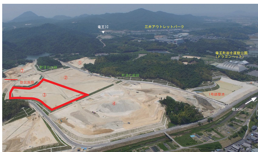
写真：滋賀竜王工業団地周辺 赤枠内は当社新工場建設予定地
