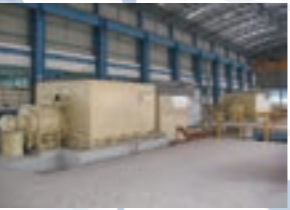
バイオマス発電システム Biomass power generation system
