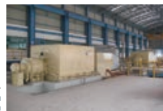
バイオマス発電システム Biomass power generation system
