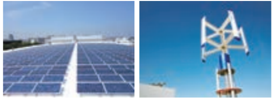
横浜製作所の屋上に設置している太陽光発電パネルと風力発電機 Rooftop solar panels and wind power generation system at the Yokohama Plant
