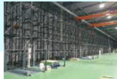
TDS(自動倉庫システム)の活用
