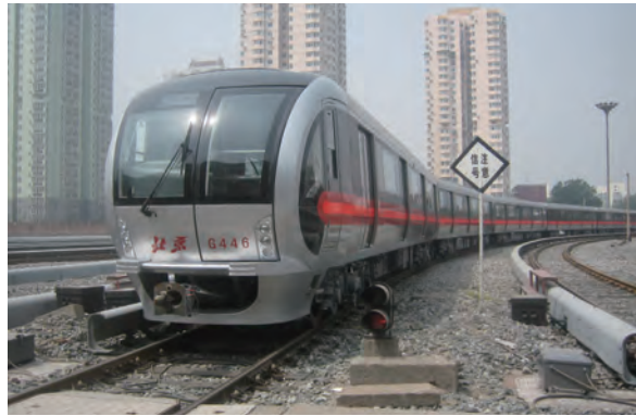
北京地下鉄1号線(2007年)
