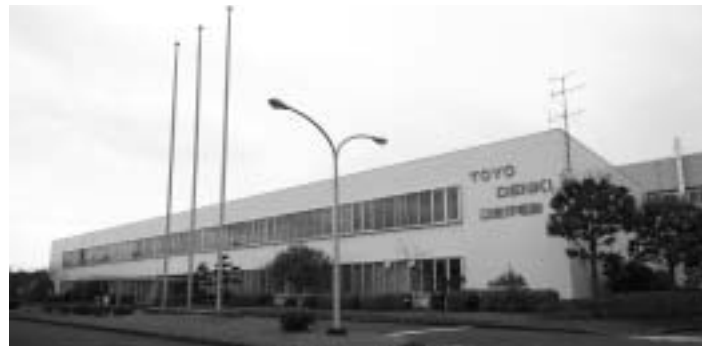
1985年6月より操業を開始した横浜製作所。ここで鉄道車両用のパンタグラフ、主制御装置、主電動機などが生み出されている。
