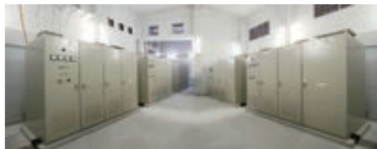
鉄道用電力貯蔵装置 E 3 ソリューションシステム (東武鉄道株式会社へ納入)
