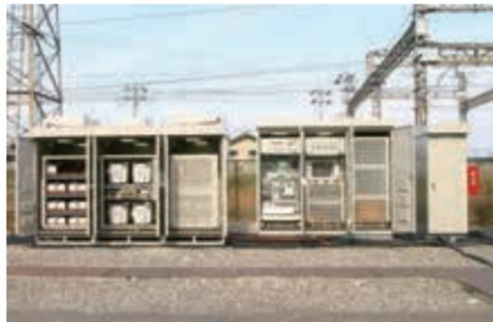
鉄道用電力貯蔵装置「E³ Solution System」(2006年)
