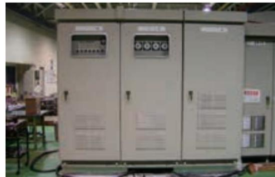
鉄道用電力貯蔵システム試作機(2006年 JR西日本納入)
